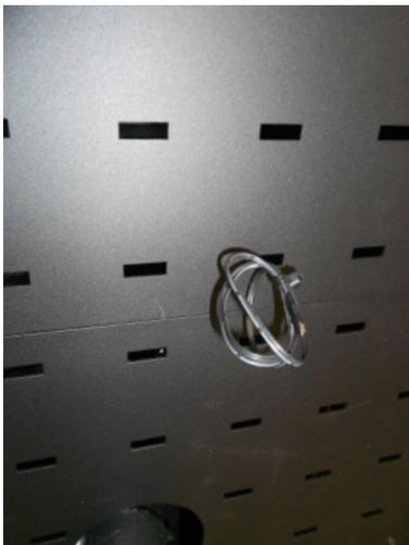
**Figura 10 - Sonda de temperatura ambiente**
