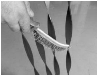
Figura 26 – Limpeza dos canais de passagem de ar e turbuladores
