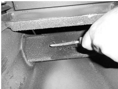
Figura 24 - Limpeza do interior da caldeira
