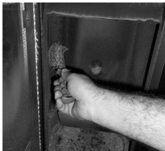
Figura 24 - Limpeza do interior da caldeira
